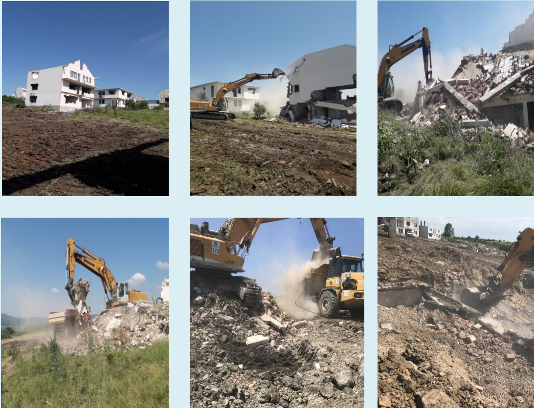
Rrenimi i objekteve dhe bartja e materialit të rrenuar, nga lagja Mirena-Hade
